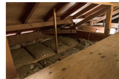
20年以上前の家だけど屋根裏には断熱材がぎっしり
