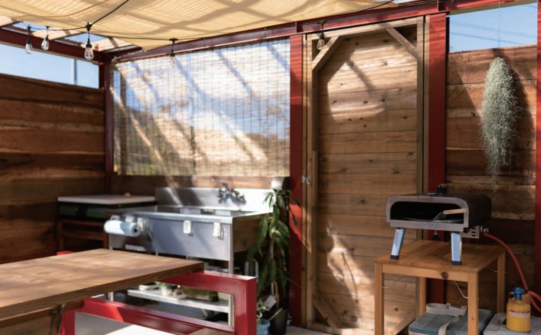
H 鋼と枕木で構成された半外空間 GOOD-TIME PLACE は、完成したばかりでもどこか味わいがある
