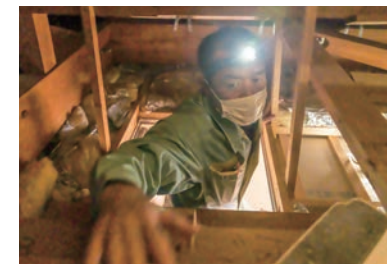
屋根裏を点検中
